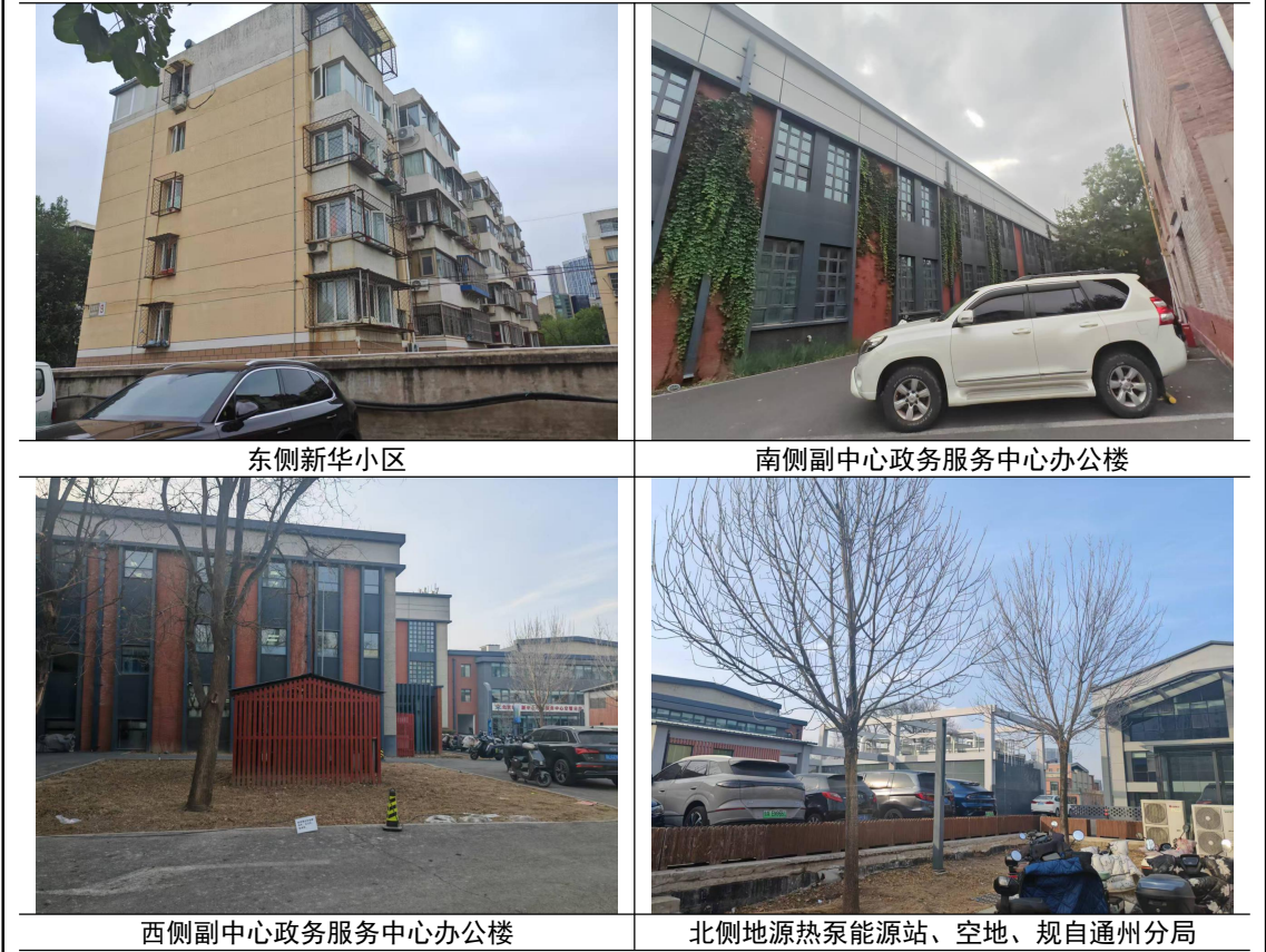
图 3 本项目锅炉房周边四周现状
